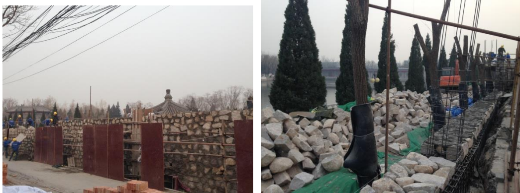
图 4-22 2016 年 12 月正在重砌西墙
