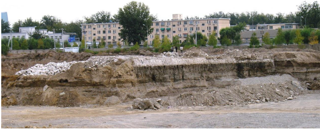
图 8-10 2007 年 11 月正在拆除的阅武楼遗址
